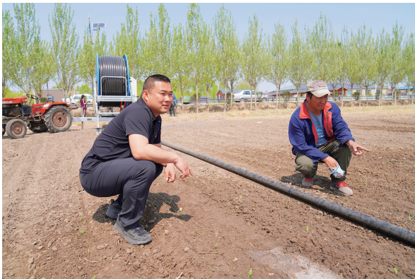
驻村第一书记查看水肥一体化设备安装情况
