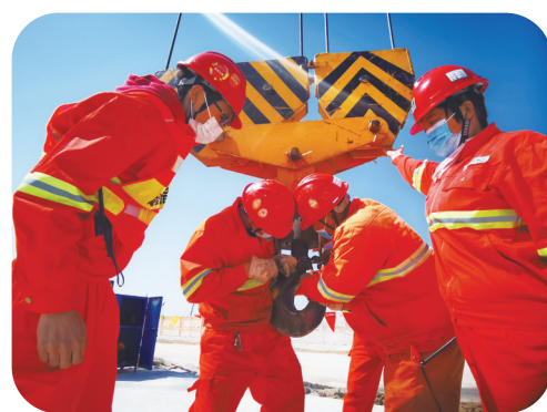
起重工齐心协力进行设备吊装前检查
