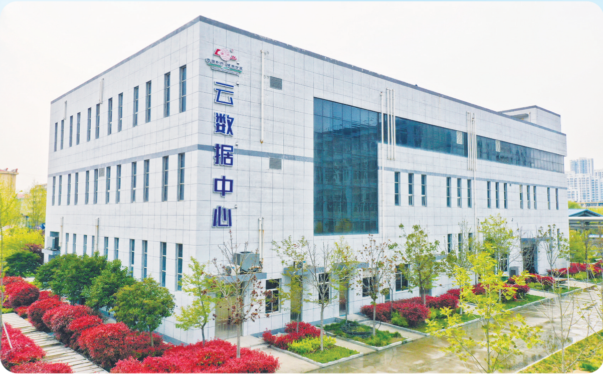
鲁南制药集团云数据中心
