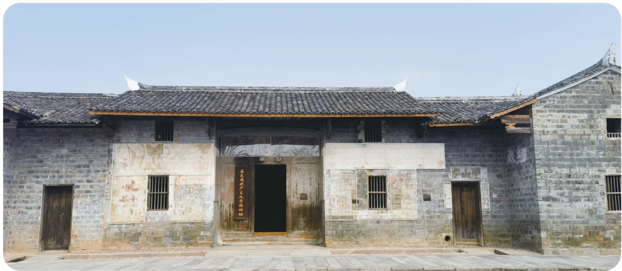
修缮后的洋溪村马克思共产主义学校旧址（2023年）
