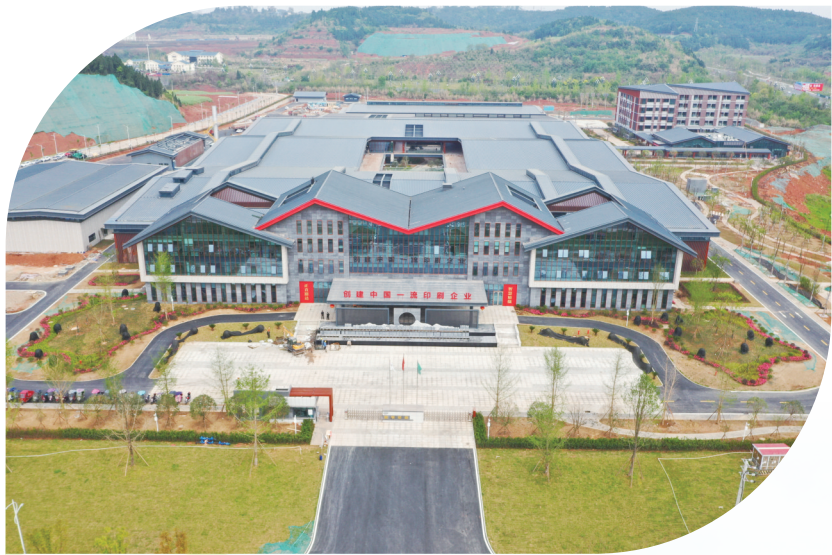
处在成渝地区双城经济圈的宽窄印务扩能项目
