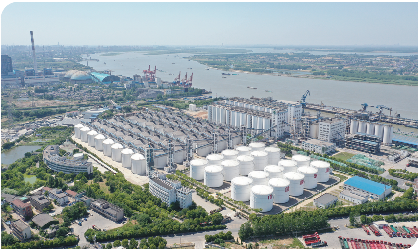
中央储备粮镇江直属库
