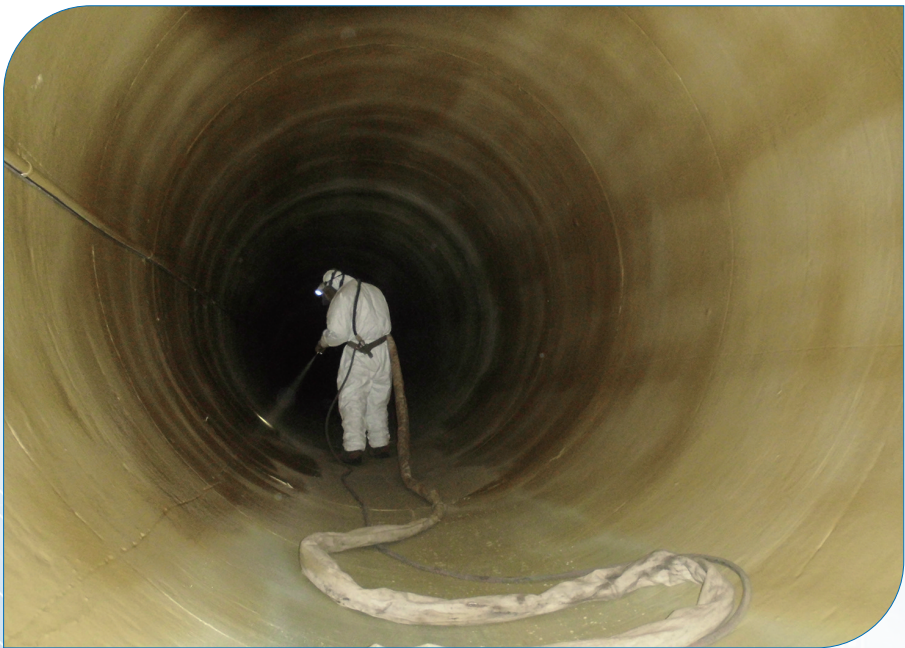
工作人员针对严重结构问题通过喷涂工艺对管网结构进行加固
