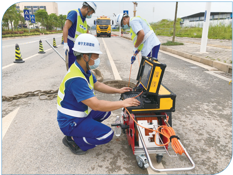
工作人员正在对排水管道内部功能及结构问题进行全方位检测
