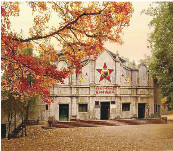
中华苏维埃共和国临时中央政府第一次代表大会（一苏大）旧址
