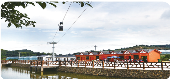
正在运行的智运快线 陶明/摄
