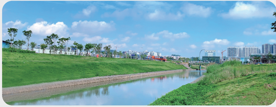
完成整治的朝阳溪河道综合整治工程荣宝龙段河道
