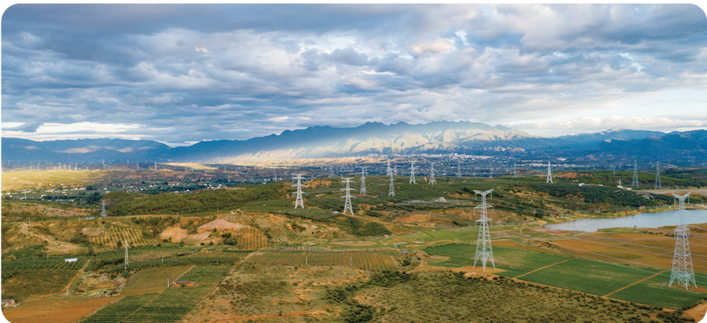
新建成投运的雅中特高压工程
