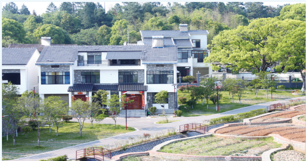
华容县三封寺镇莲花堰村美丽乡村建设示范村
