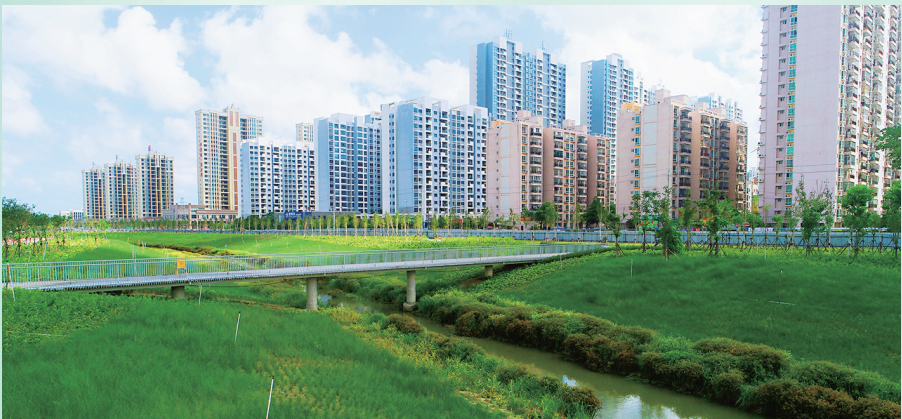
位于城市绿廊区15号地的植被缓冲带
