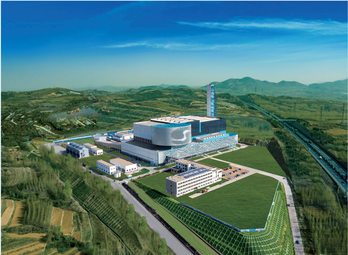
青岛西海岸新区静脉产业园 规模：一期2250 t/d，二期1500 t/d
