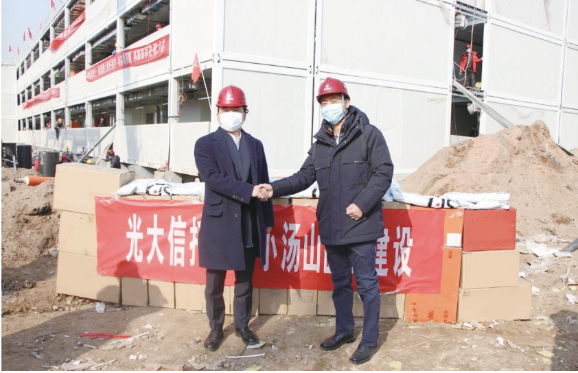
光大信托党委书记、董事长闫桂军赴小汤山医院扩建工程施工现场慰问
