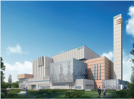
光山县垃圾焚烧发电厂PPP项目 规模：1200吨/日
