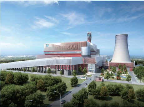
嘉兴市区生活垃圾焚烧处理提升改造项目 规模：1950吨/日
