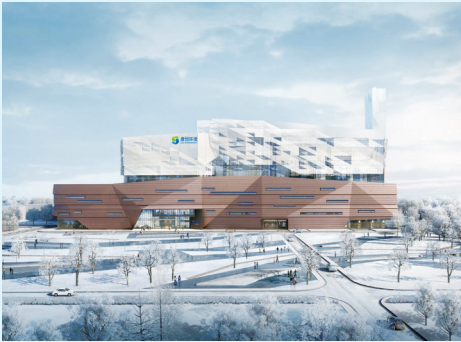
三河市静脉产业园生活垃圾焚烧发电PPP项目 规模：2000吨/日
