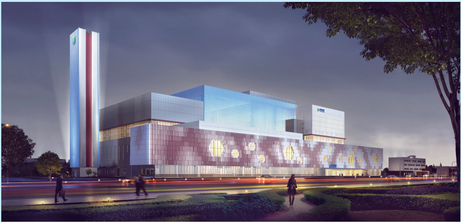
康恒环境投资建设的西安高陵垃圾焚烧发电项目，是西安垃圾焚烧的代表性项目
