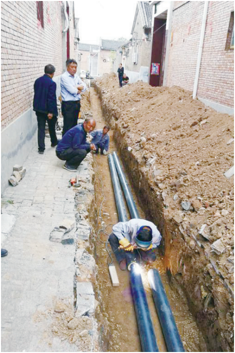
集中供热管网施工现场
