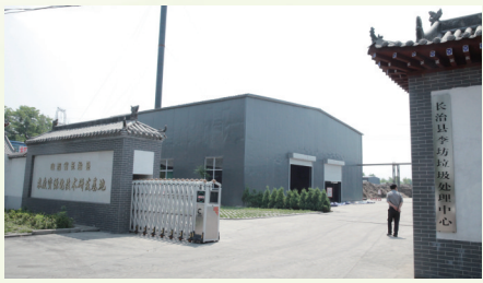
上党区李坊村垃圾处理中心
