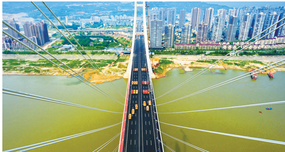
长江上游第一座公轨两用钢桁梁斜拉桥——重庆鼎山长江大桥斜拉桥顺利通车
