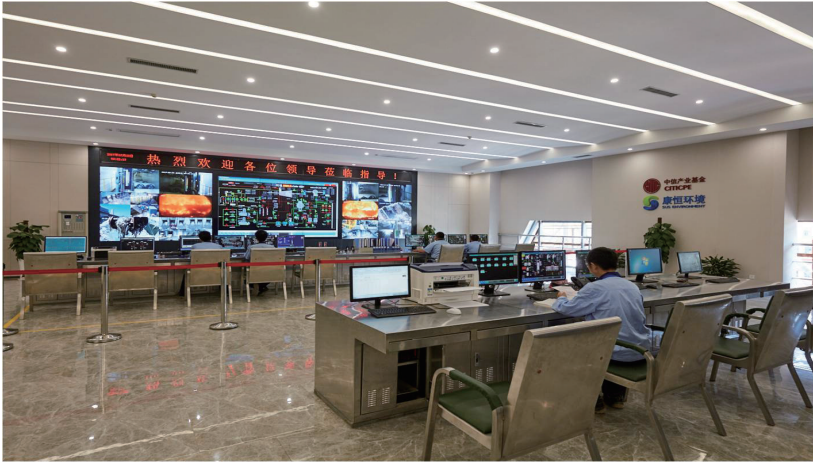
●整个厂区，洁净明亮，空气清新，总控室掌控整个密闭的生产过程
