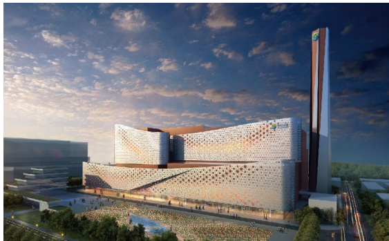
青岛小涧西生活垃圾焚烧发电项目 日处理2250吨
