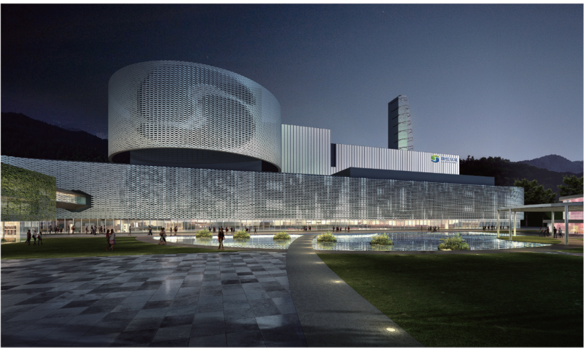
黄岛生活垃圾焚烧发电项目 日处理1期 2250 吨
