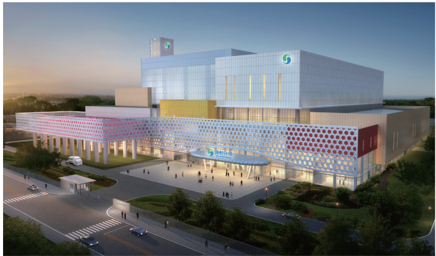
太原生活垃圾焚烧发电项目 日处理3000吨
