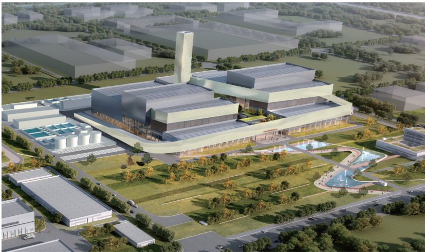
杭州临江环境能源工程项目 日处理5200吨
