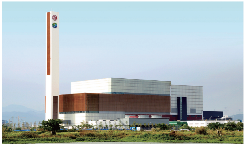
珠海中信环保产业园 日处理1期1200吨 / 2期1800吨
