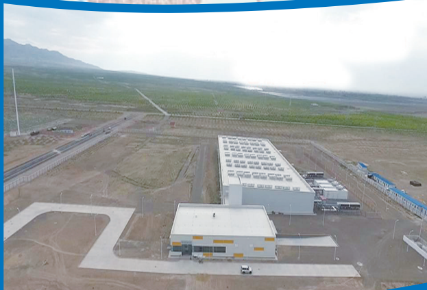
亚马逊D点数据中心航拍图
