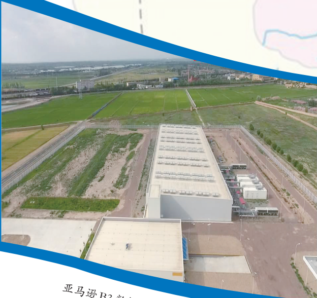
亚马逊B3数据中心航拍图
