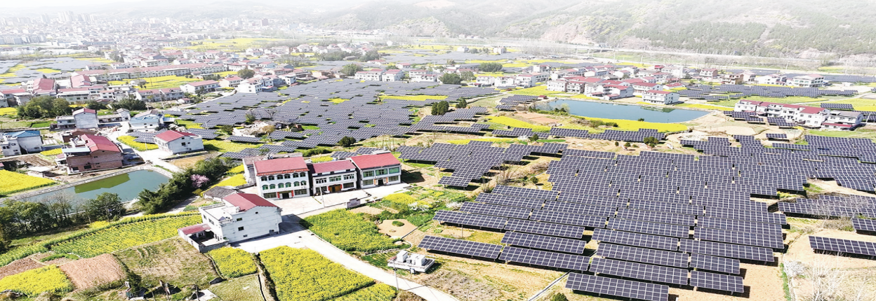
华电陕西农光互补光伏发电项目
