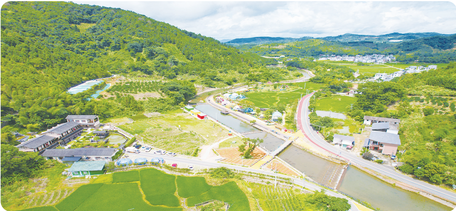
三百山镇咀下村“客且留下·共富共行”党建引领乡村振兴示范点
