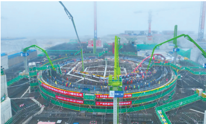
我国首个“华龙一号”批量化建设项目漳州能源3号机组开工
