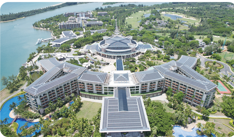
博鳌近零碳示范区
